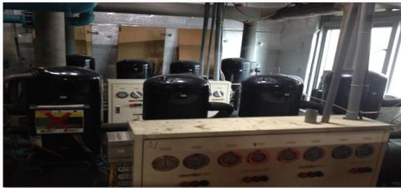
全廠配置水冷式冰水主機共計 4 組，每組 60 噸，共計 240 噸，水冷式冰水主機運轉效率佳，可視需求，調整壓縮機運轉的數量，達到節能的目的。
